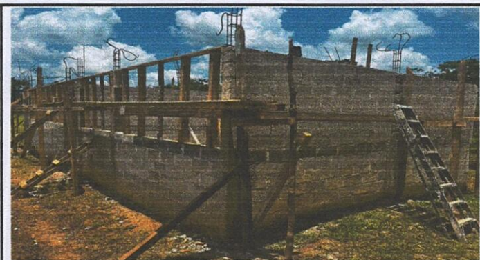
Foto 3: Se observa la pared que se está levantando y las bases de los dinteles para los marcos de las ventanas.
