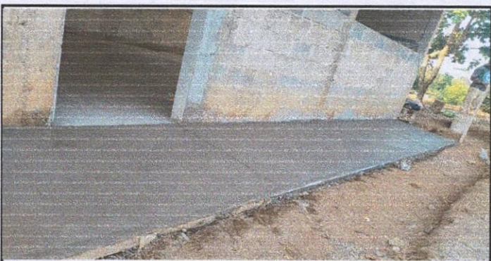
Foto 6: Se observa la fundición de un pequeño corredor en la parte frontal de las aulas.
