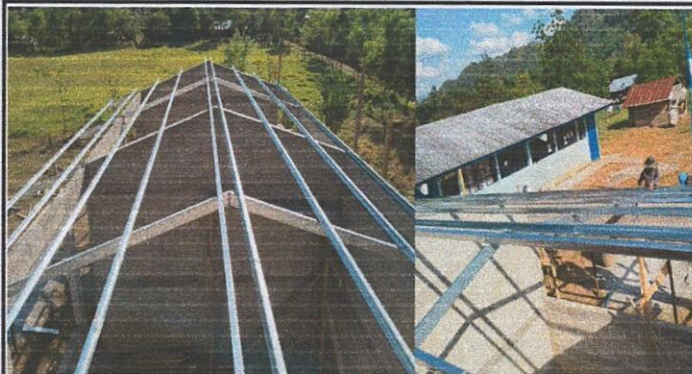
Foto1: Se observa la estructura metálica para el techo de las aulas, así mismo los mojinetes de block.
