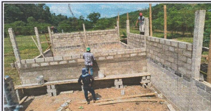
Foto 6: Se observa el levantado de la pared de división del aula para hacer de ella dos aulas, así mismo se observa los otros levantados que se están haciendo.
