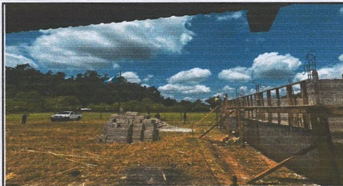
Foto 2: Se visualiza el inicio de los trabajos con el material de construcción y la colocación de andamios para el levantado de pared.
