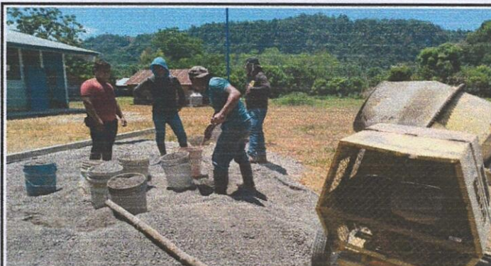
Foto 3: Se observa a los albañiles preparando el concreto para la fundición de la torta para el piso de las aulas.
