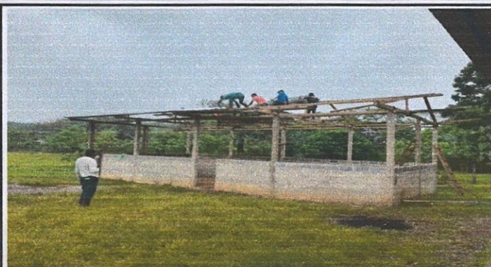
Foto1: Desmontaje de la estructura de madera y las paredes de madera que tenía las aulas a remozar.
