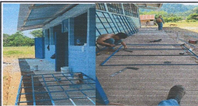
Foto 5: Se aprecia al herrero soldando la estructura para las ventanas, así mismo las puertas recién colocadas.
