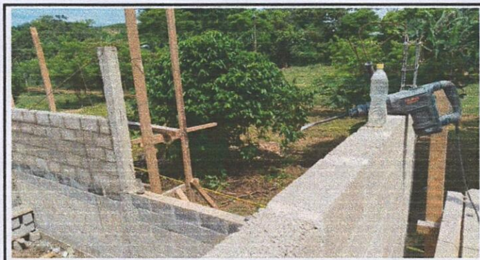
Foto 4: Vista desde el ángulo aéreo de la pared en construcción de la parte trasera de las aulas.
