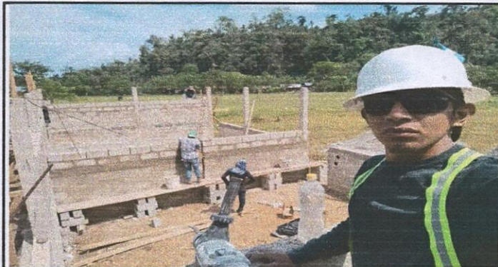
Foto 2: Se visualiza a uno de los albañiles desde uno de los extremos de la construcción.
